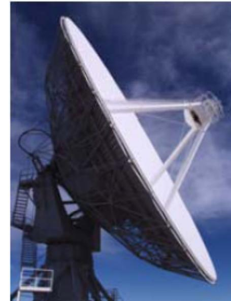
Utiliza como subreflector un casquete de hiperboloide de revolución con un foco común al del reflector parabólico principal. Sobre el otro foco se sitúa el centro de fase del alimentador.
